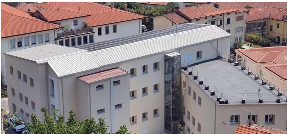
Figura 9. Intervento trasformazione nZEB Municipio, Serravezza
