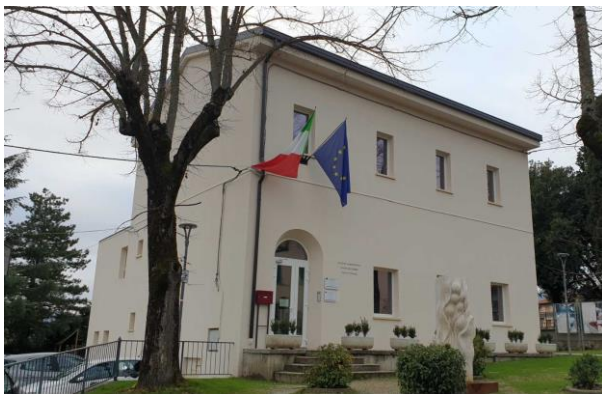
Figura 7. Intervento trasformazione nZEB Scuola Meleto, Cavriglia
