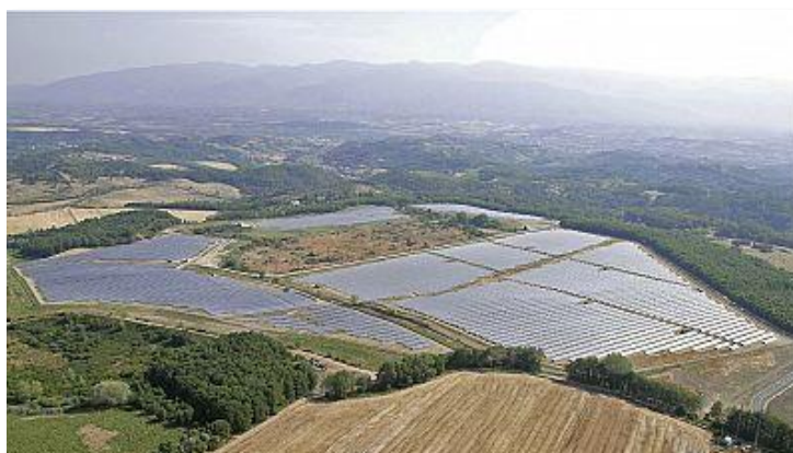
Figura 4. Impianto FV di Santa Barbara a Cavriglia
