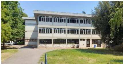
Figura 5. Intervento di sostituzione degli infissi Scuola del Puglia, Figline e Incisa Valdarno
