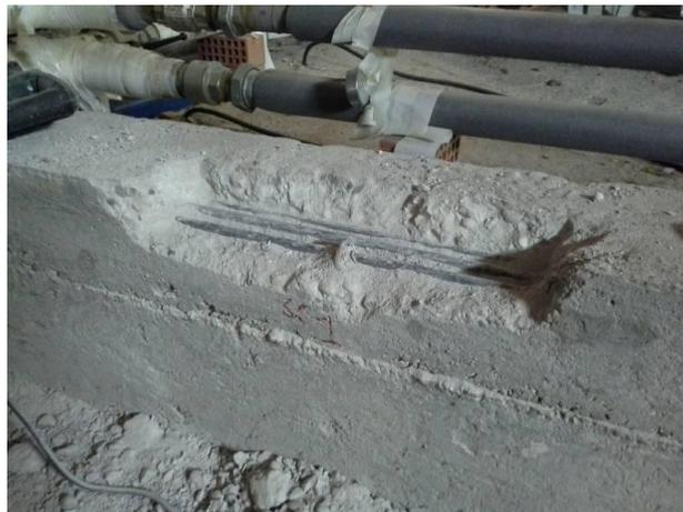
La barra viene quindi asportata per tale lunghezza tramite taglio con mola. Il ripristino della barra in acciaio sarà effettuato mediante barra ad aderenza migliorata, mediante saldatura, avente diametro uguale o maggiore dell'elemento da ripristinare. La saldatura sarà effettuata ad elettrodo, preferibilmente mediante semplice sovrapposizione per una lunghezza del cordone pari a circa 10 volte il diametro della barra da ripristinare su ciascun lato.
